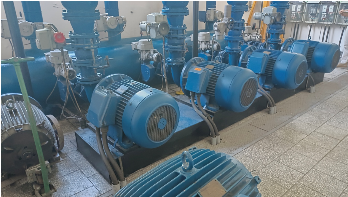
Fot. 5.2 Przepompownia Staszic – posadowienie agregatów pompowych na fundamencie.
