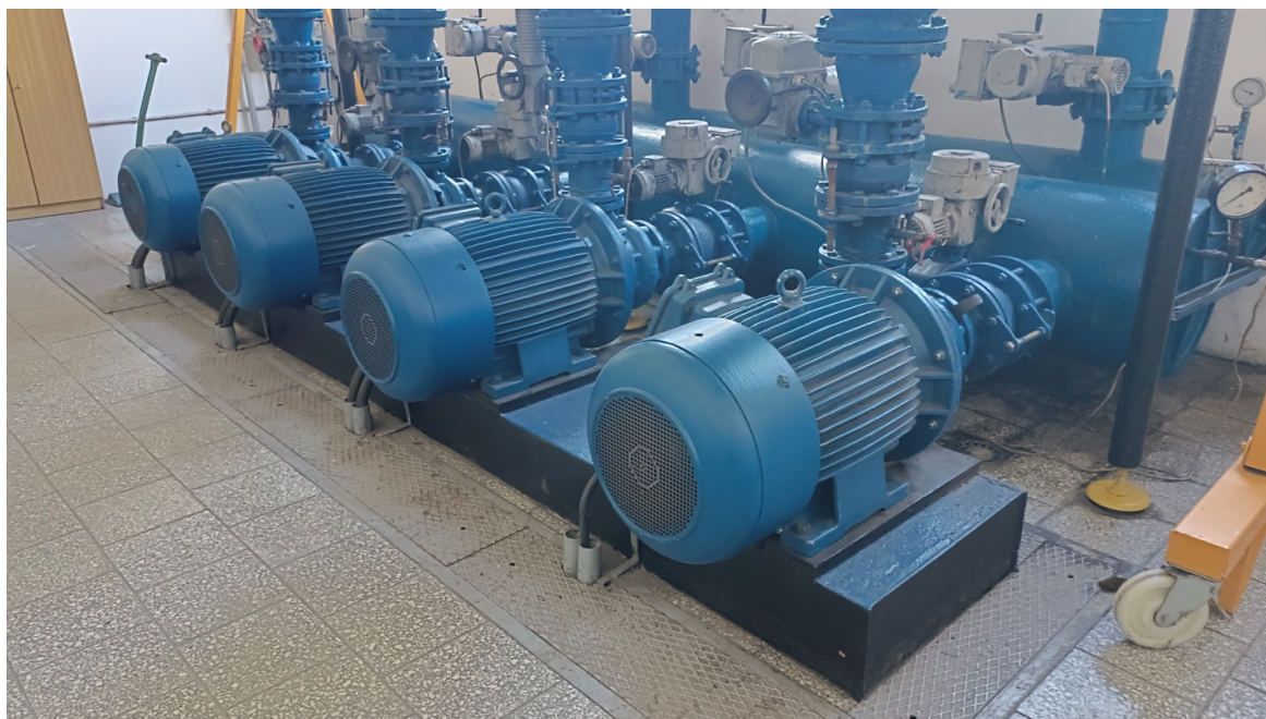
Fot. 5.1 Przepompownia Staszic – posadowienie agregatów pompowych.
