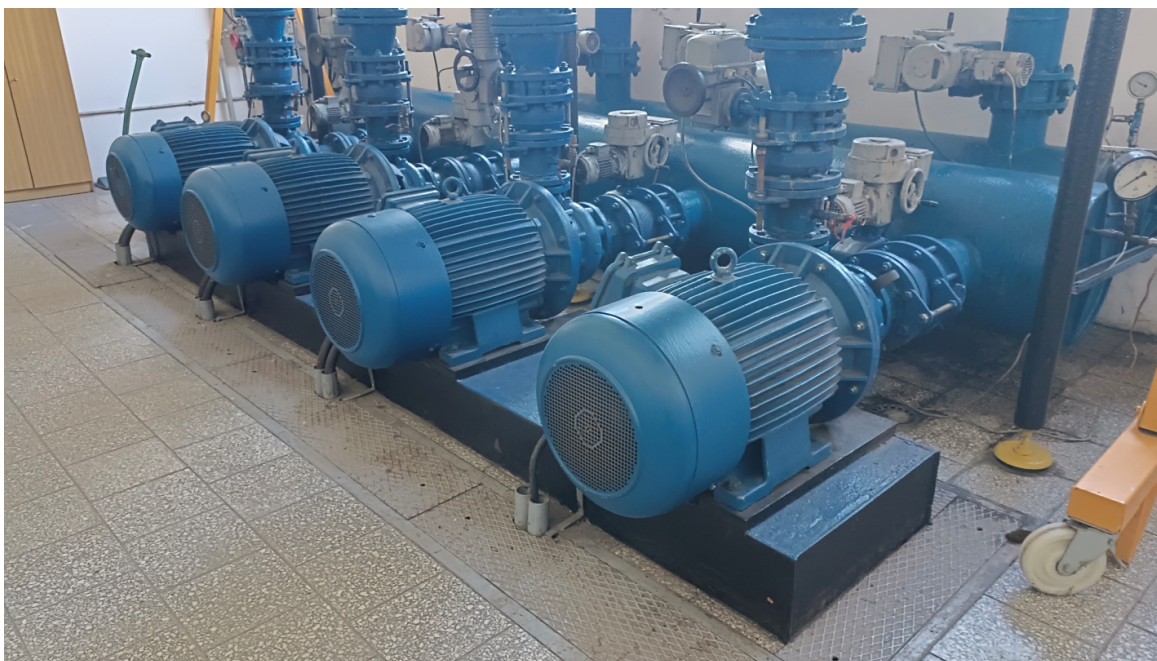
Rys.3.1 Przepompownia Staszic – posadowienie istniejących agregatów pompowych.
