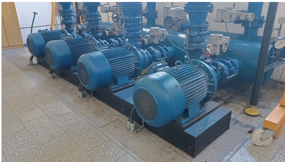
Rys.2.1 Przepompownia Staszic – posadowienie agregatów pompowych.
